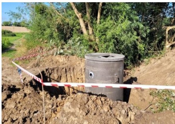
Fot. 4.8.15-16. Budowa sieci kanalizacji sanitarnej przy ul. Grudziądzkiej w Jabłonowie Pomorskim (fot. UMiG Jabłonowo Pomorskie)
