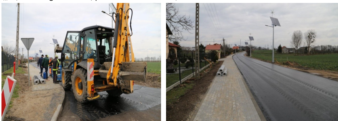
Fot. 4.8.1-2. Przebudowa drogi gminnej w miejscowości Piecewo (fot. UMiG Jabłonowo Pomorskie)
