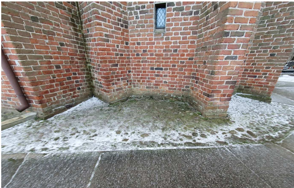
Fot.23. Lembarg, parafia pw. św. Piotra i Pawła. Fragment terenu przykościelnego z nawierzchnią z kamienia polnego (bezpośrednio przy elewacji).
