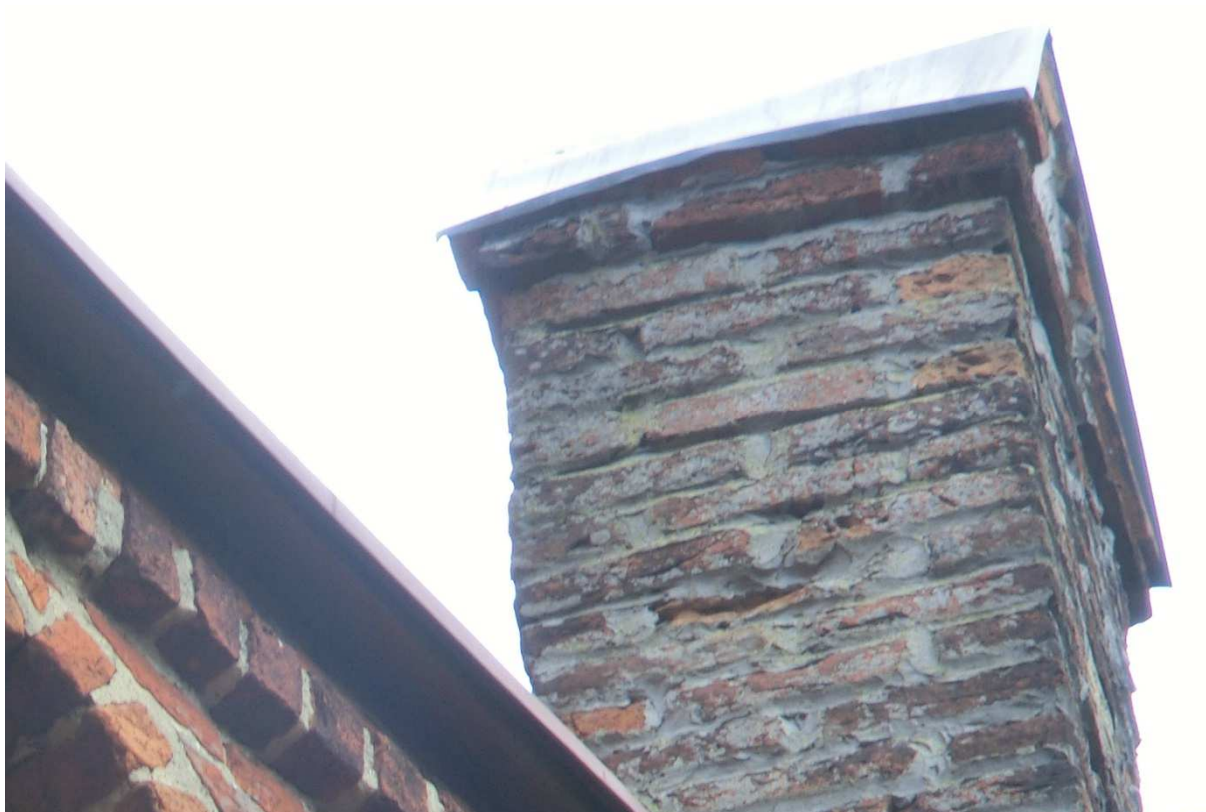
Fot.15. Lembarg, parafia pw. św. Piotra i Pawła. Ślady prowizorycznych napraw na sterczynie.
