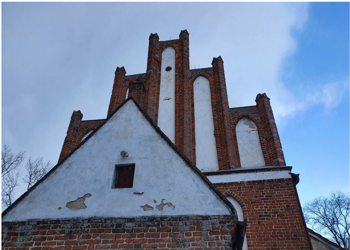
Fot.22. Lembarg, parafia pw. św. Piotra i Pawła. Stan zachowania tynków na szczycie prezbiterium i zakrystii.
