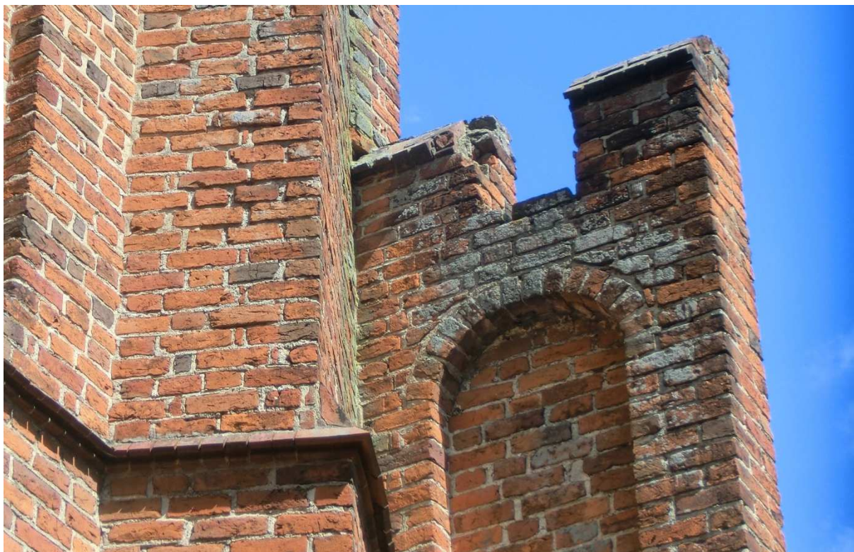
Fot.13. Lembarg, parafia pw. św. Piotra i Pawła. Sterczyny szczytu zachodniego, przy wieży. Ubytki kształtek.
