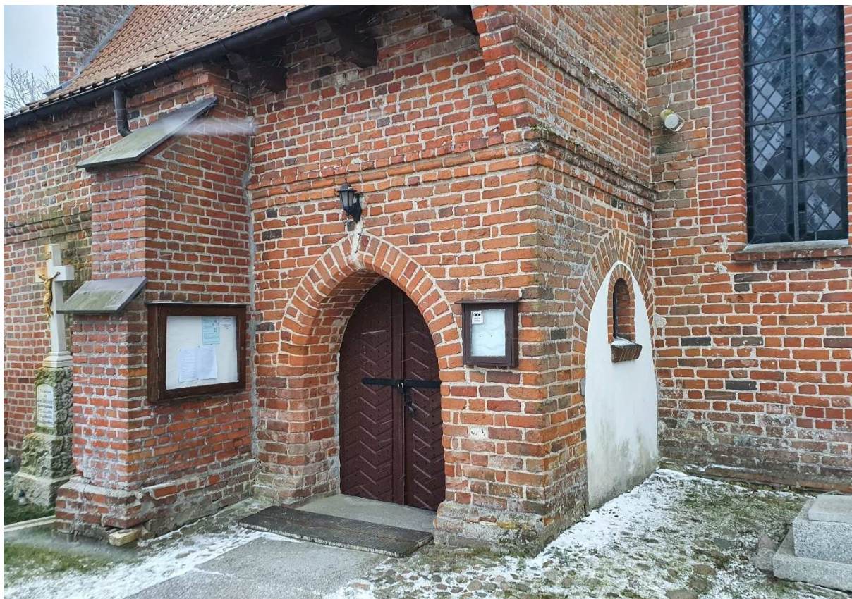
Fot.5. Lembarg, parafia pw. św. Piotra i Pawła. Widok ogólny na kruchtę północną i kaplicę.
