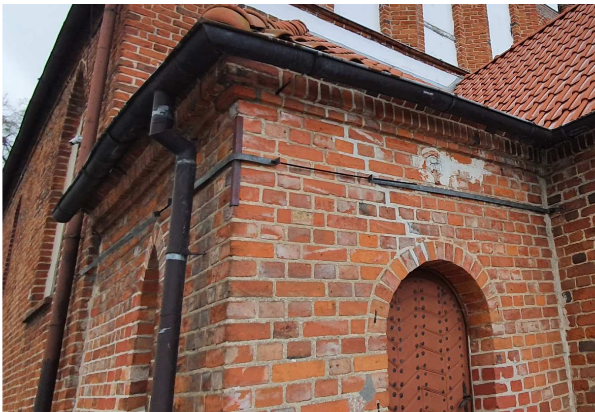
Fot.8. Lembarg, parafia pw. św. Piotra i Pawła. Przybudówka zakrystii. Na zdjęciu widoczne kotwy spinające koronę muru.
