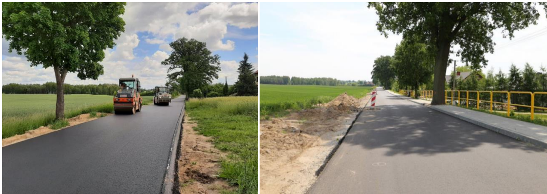
Fot. 4.8.9. i 4.8.10. Przebudowa drogi gminnej Konojady – Tomki. (źródło: UMiG Jabłonowo Pomorskie)
