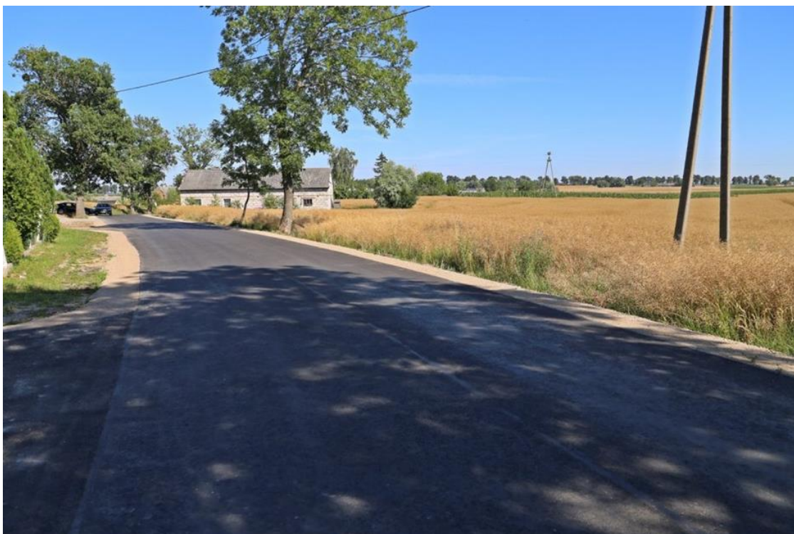
Fot. 4.8.3. Przebudowa drogi gminnej Buk Pomorski – Świecie nad Osą, etap II. (źródło: UMiG Jabłonowo Pomorskie)
