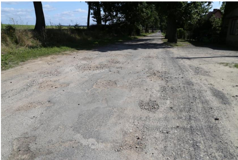
Fot. 4.8.6. Stan drogi gminnej Konojady – Tomki przed przebudową. (źródło: UMiG Jabłonowo Pomorskie)
