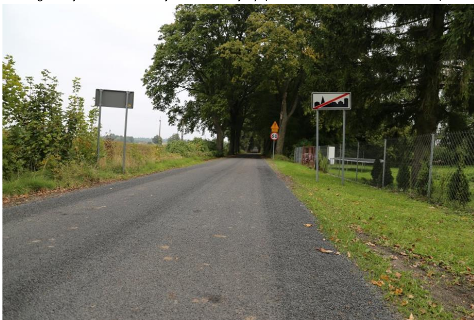
Fot. 4.8.14. Wykonane powierzchniowe utwalenie emulsją asfaltową i grysem kamiennym drogi gminnej nr 080102C w miejscowości Konojady. (źródło: UMiG Jabłonowo Pomorskie)
