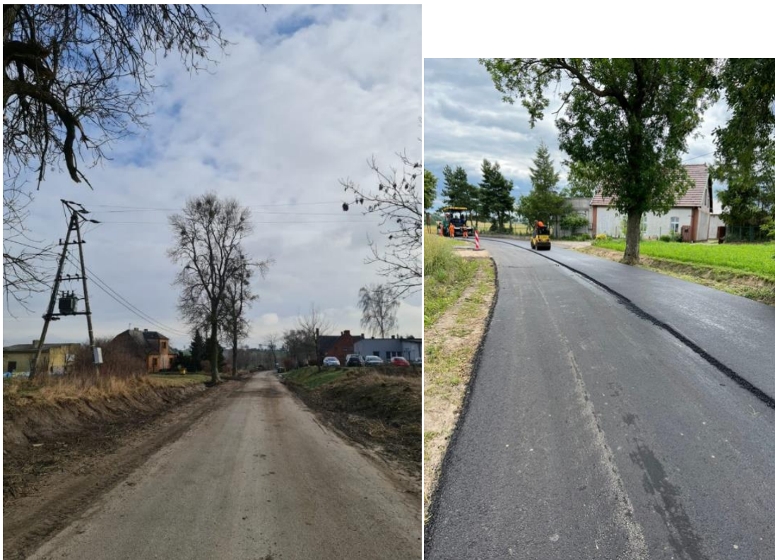
Fot. 4.8.1. i 4.8.2. Przebudowa drogi gminnej Buk Pomorski – Świecie nad Osą, etap II. (źródło: UMiG Jabłonowo Pomorskie)
