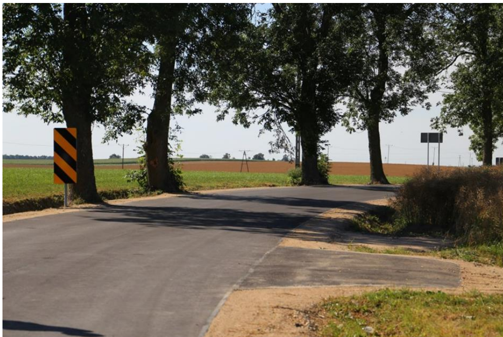
Fot. 4.8.4. Przebudowa drogi gminnej Buk Pomorski – Świecie nad Osą, etap II. (źródło: UMiG Jabłonowo Pomorskie)
