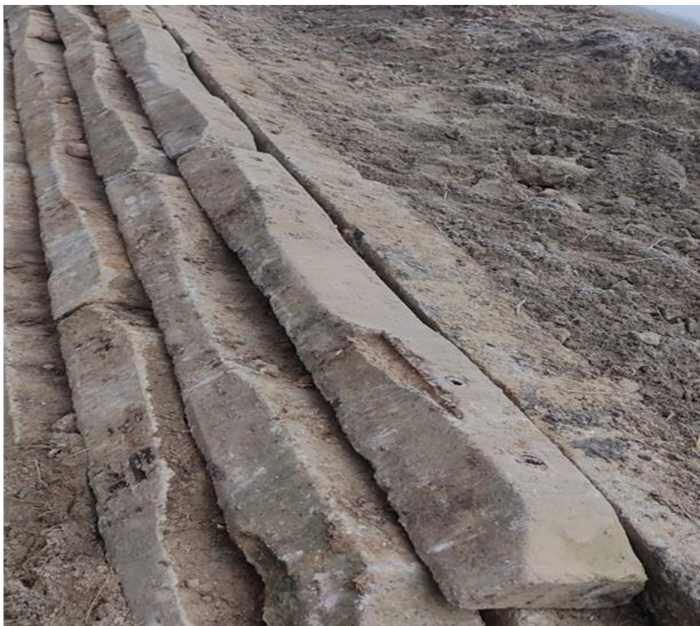
Fot. 5.7.1. Wzmocnienie przyczółku mostu w Bukowcu (źródło: ZUK w Jabłonowie Pomorskim)
