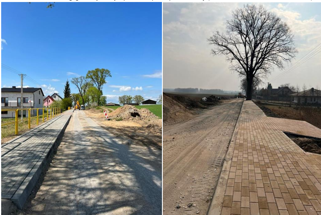
Fot. 4.8.7. i 4.8.8. Przebudowa drogi gminnej Konojady – Tomki. (źródło: UMiG Jabłonowo Pomorskie)
