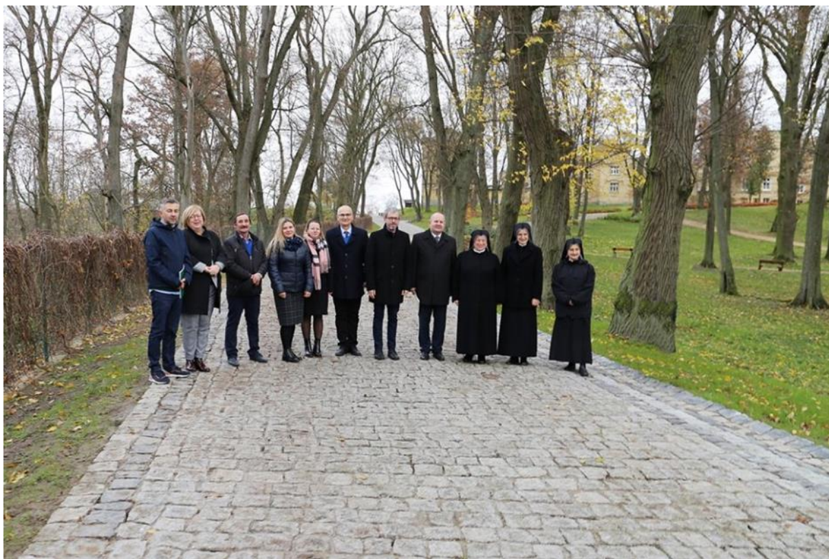
Fot. 4.8.18. Odbiór drogi gminnej nr 080155C w miejscowości Jabłonowo-Zamek po przebudowie. (źródło: UMiG Jabłonowo Pomorskie)
