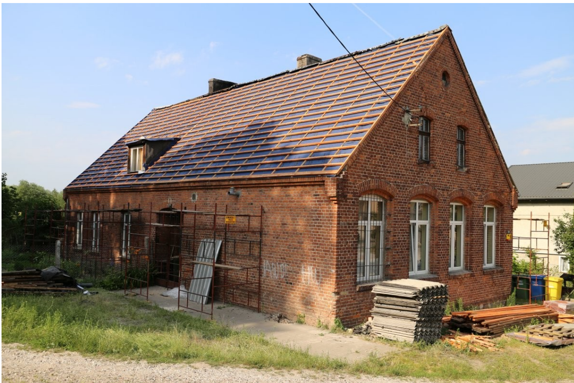
Fot. 6.8. Budynek mieszkalny w Jabłonowo-Zamek 11 w trakcie modernizacji dachu (źródło: ZGKiM w Jabłonowie Pomorskim)
