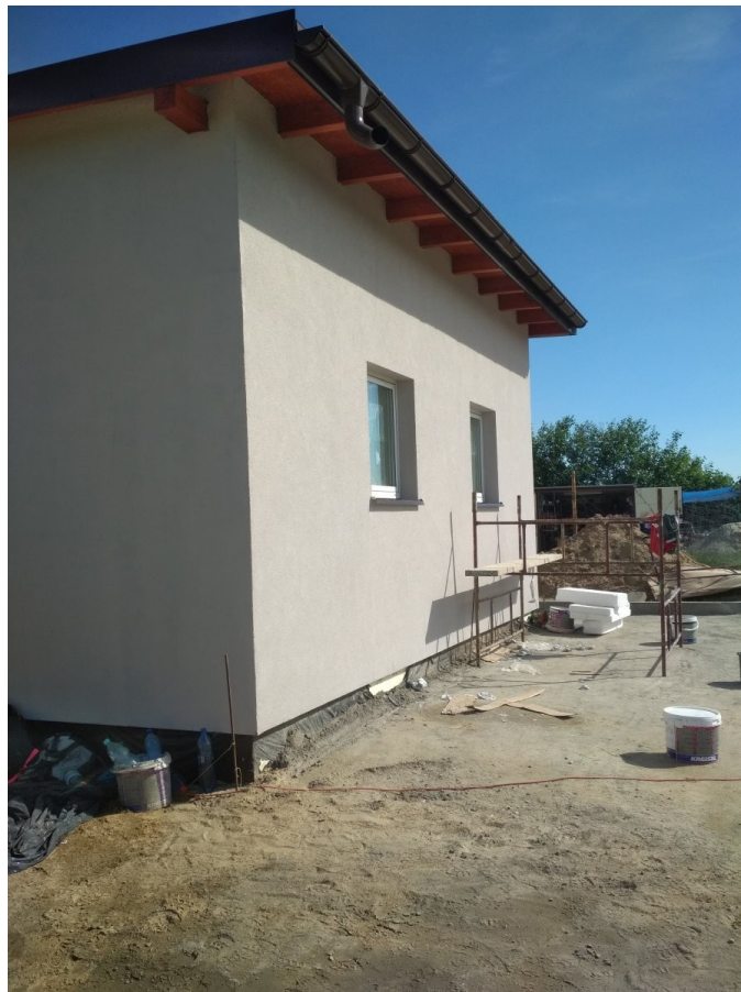
Fot. 6.7. Budynek mieszkalny w Buku Pomorskim w trakcie modernizacji (źródło: ZGKiM w Jabłonowie Pomorskim)
