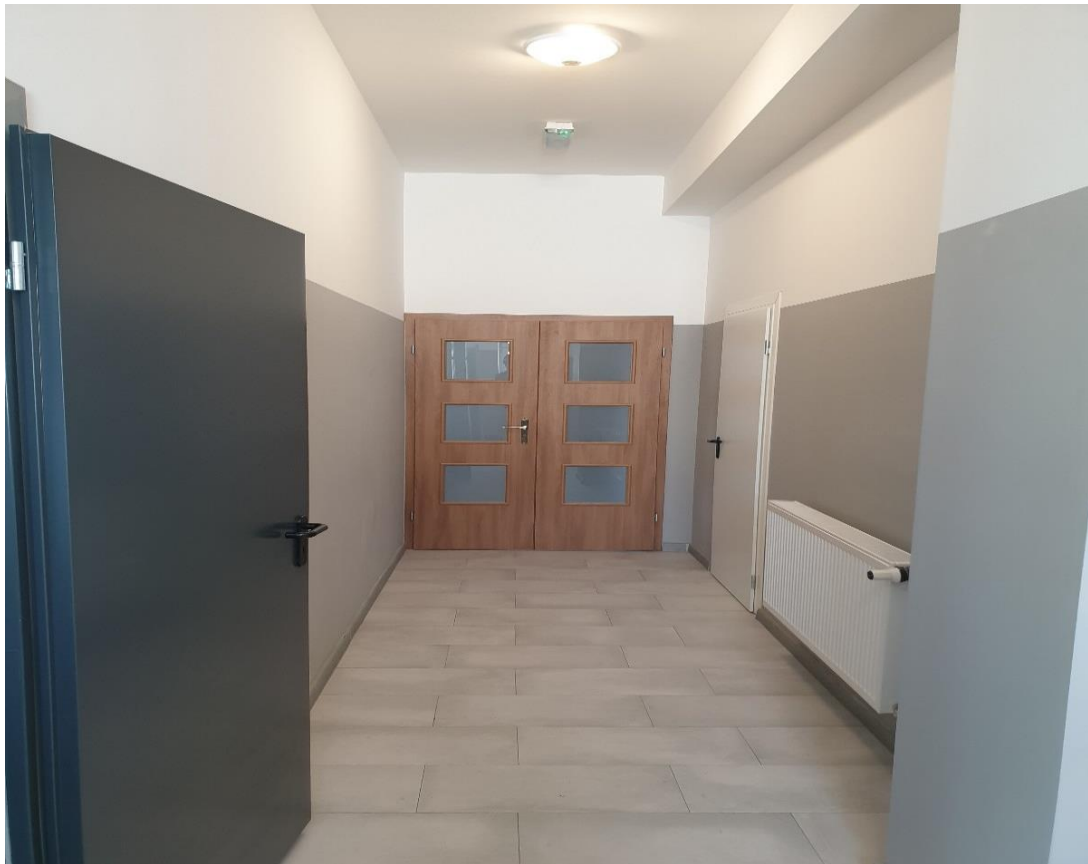
Fot. 4.24. Modernizacja i remont pomieszczeń budynku OSP w Jabłonowie Pomorskim (źródło: UMiG Jabłonowo Pomorskie)
