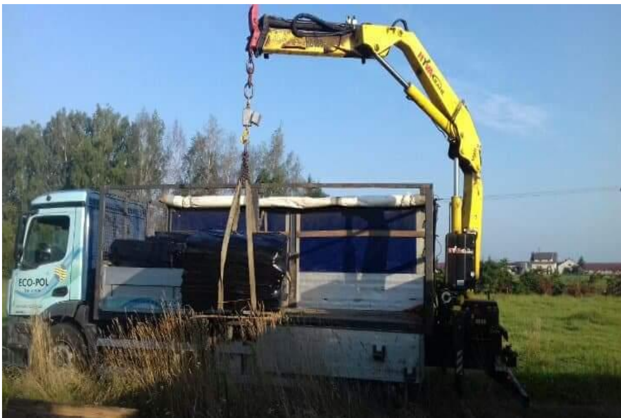
Fot. 4.10. Demontaż, transport i unieszkodliwienie wyrobów zawierających azbest z terenu Miasta i Gminy Jabłonowo Pomorskie (źródło: UMiG Jabłonowo Pomorskie)
