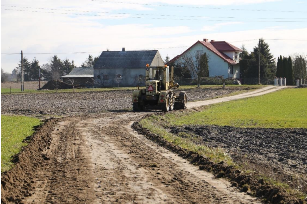
Fot. 4.1. Równiarka podczas pracy (źródło: UMiG Jabłonowo Pomorskie)
