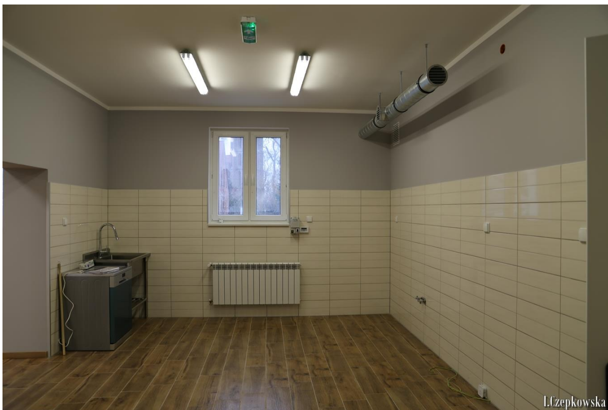
Fot. 4.16. Zmiana sposobu użytkowania części budynku użyteczności publicznej (świetlica w Lembargu) na pomieszczenia techniczne (kotłownię) wraz z jego przebudową i termomodernizacją (źródło: UMiG Jabłonowo Pomorskie)
