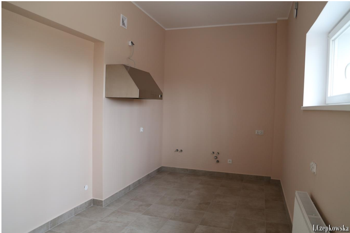
Fot. 4.19. Rozbudowa budynku użyteczności publicznej (świetlica w Nowej Wsi) wraz z jego przebudową i termomodernizacją (źródło: UMiG Jabłonowo Pomorskie)
