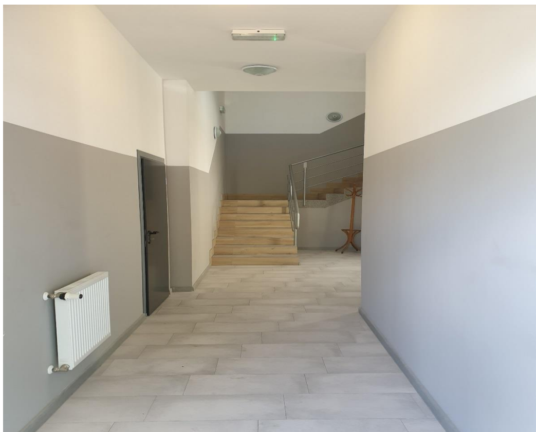
Fot. 4.22. Modernizacja i remont pomieszczeń budynku OSP w Jabłonowie Pomorskim (źródło: UMiG Jabłonowo Pomorskie)
