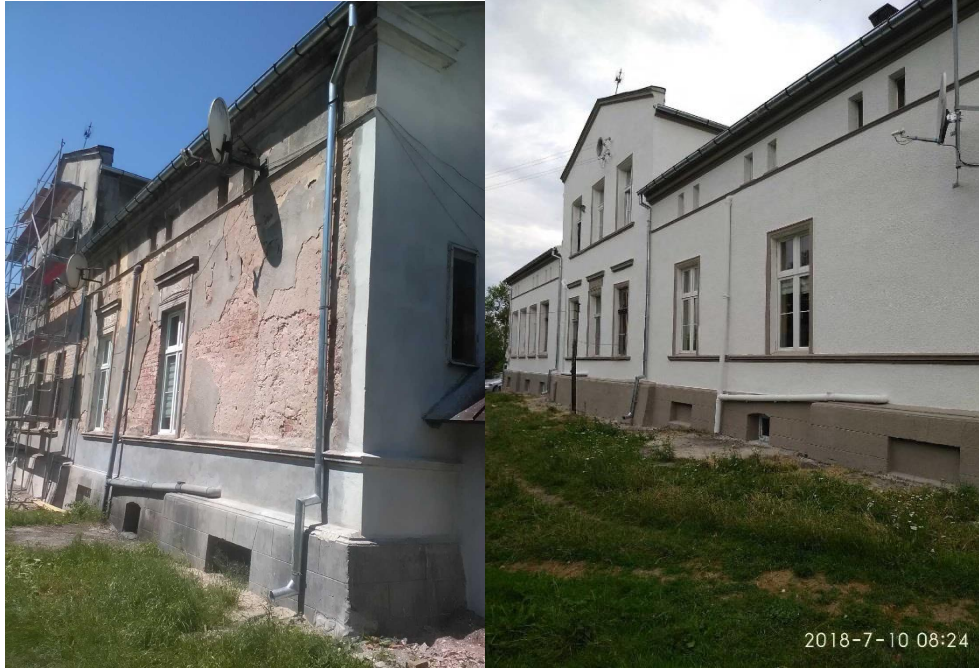
Fot. 6.4. Budynek w Konojadach 107 przed i po remoncie (źródło: UMiG Jabłonowo Pomorskie)
