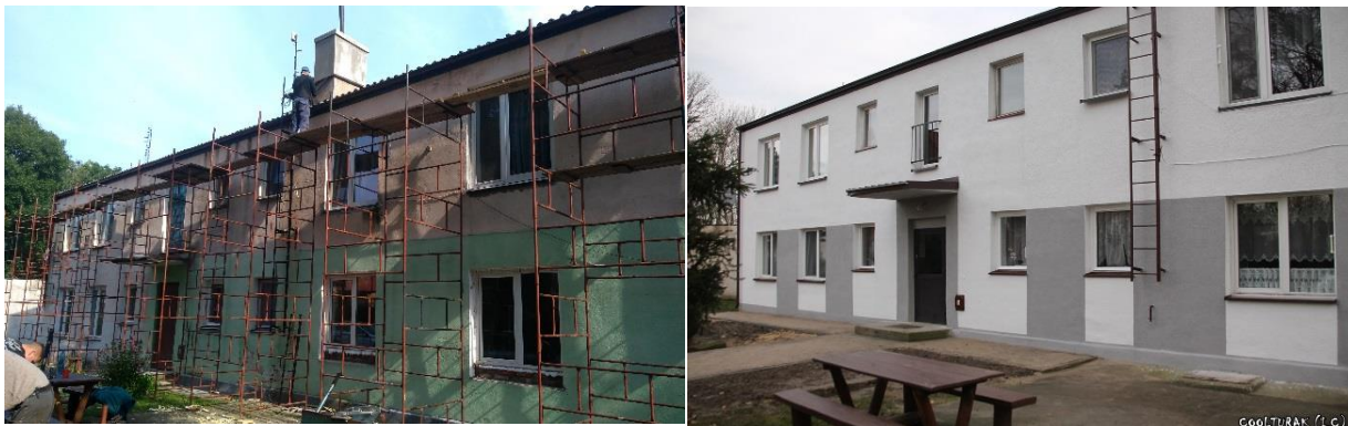
Fot. 6.1. Budynek w Lembargu przed i po modernizacji (źródło: UMiG Jabłonowo Pomorskie)
