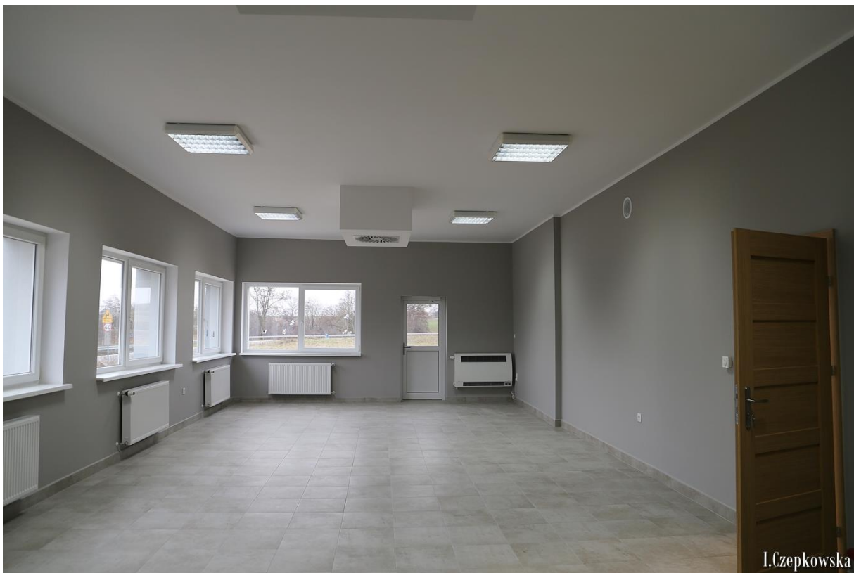
Fot. 4.18. Rozbudowa budynku użyteczności publicznej (świetlica w Nowej Wsi) wraz z jego przebudową i termomodernizacją (źródło: UMiG Jabłonowo Pomorskie)
