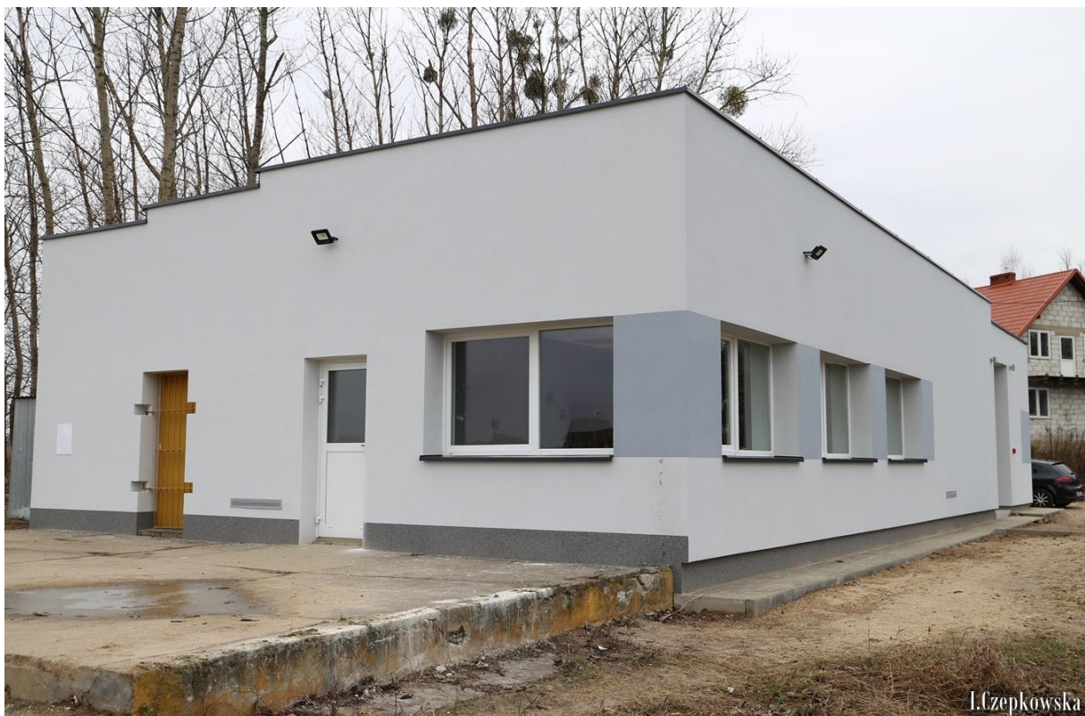
Fot. 4.20. Rozbudowa budynku użyteczności publicznej (świetlica w Nowej Wsi) wraz z jego przebudową i termomodernizacją (źródło: UMiG Jabłonowo Pomorskie)
