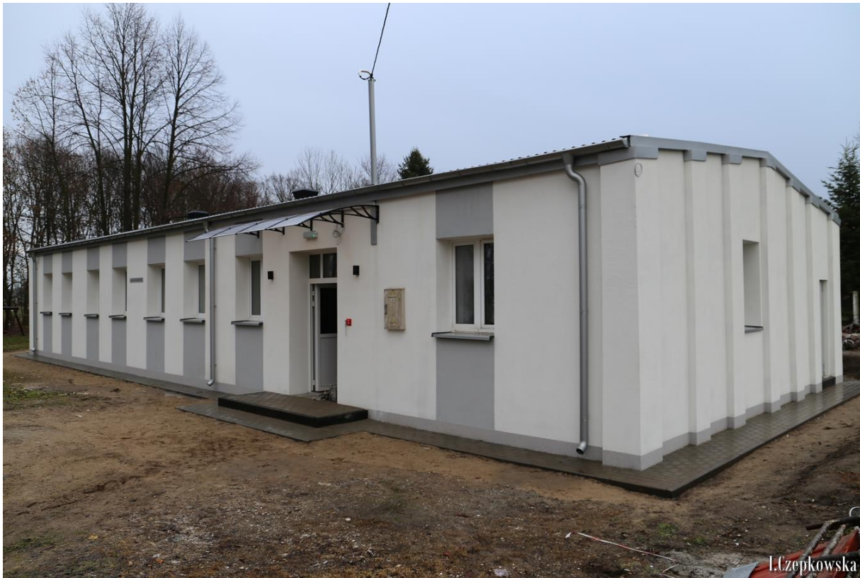
Fot. 4.17. Zmiana sposobu użytkowania części budynku użyteczności publicznej (świetlica w Lembargu) na pomieszczenia techniczne (kotłownię) wraz z jego przebudową i termomodernizacją (źródło: UMiG Jabłonowo Pomorskie)
