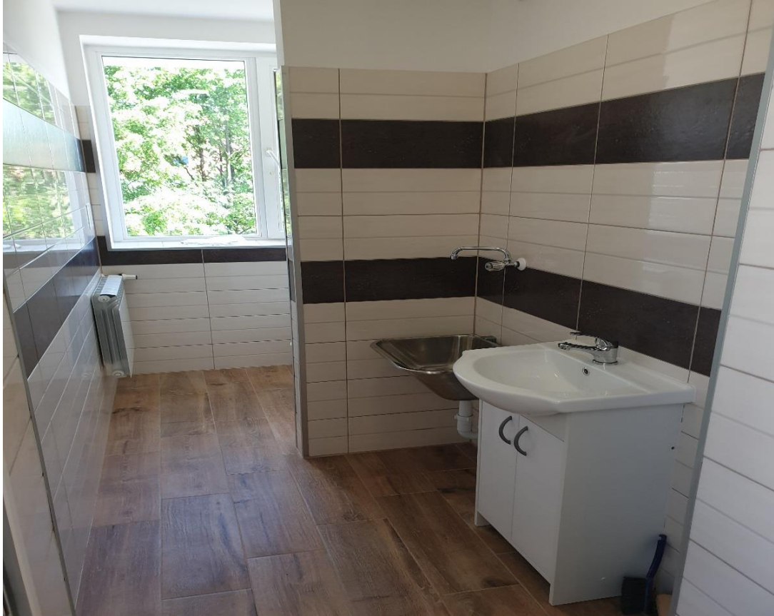
Fot. 4.23. Modernizacja i remont pomieszczeń budynku OSP w Jabłonowie Pomorskim (źródło: UMiG Jabłonowo Pomorskie)
