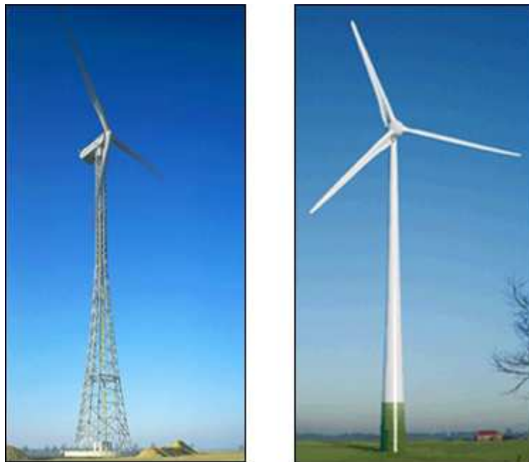
Rys. 3 Siłownie wiatrowe na konstrukcji kratowej i stalowej rurowej
